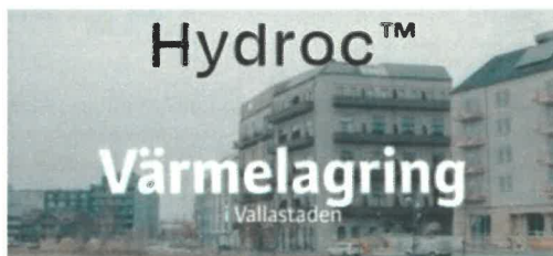
Fotot föreställer Hydroc Energy Storages projekt i Vallastaden, för en pilot i samarbete med Tekniska verken i Linköping, där Hydroc testar sin underjordiska termiska värme-/kyllager.
